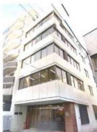
男女トイレ別 (防音扉・防音壁取付)
